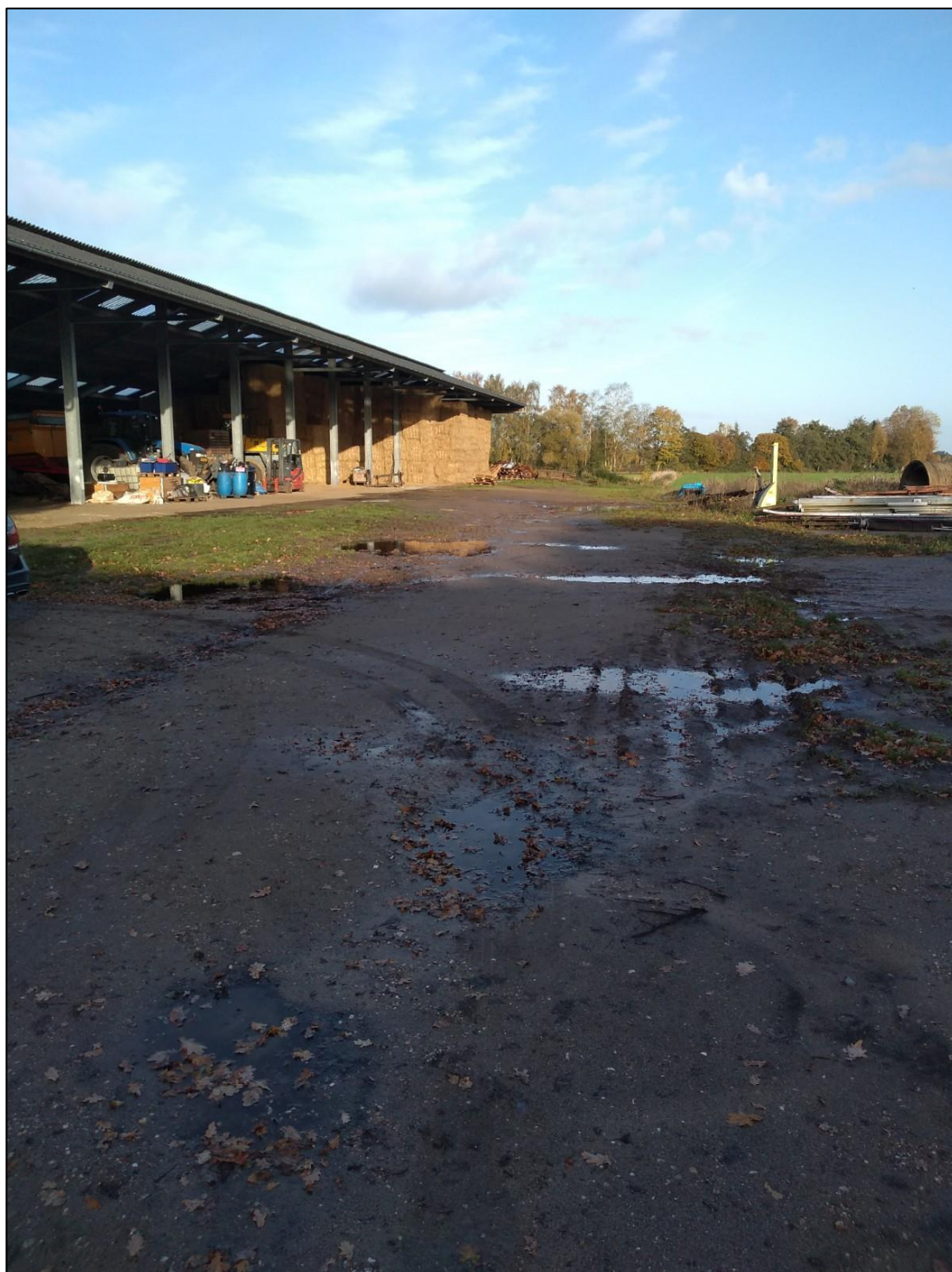
Afbeelding 12: Werktuigenloods ter plaatse van boring 1 en 2. Foto genomen richting het noorden
