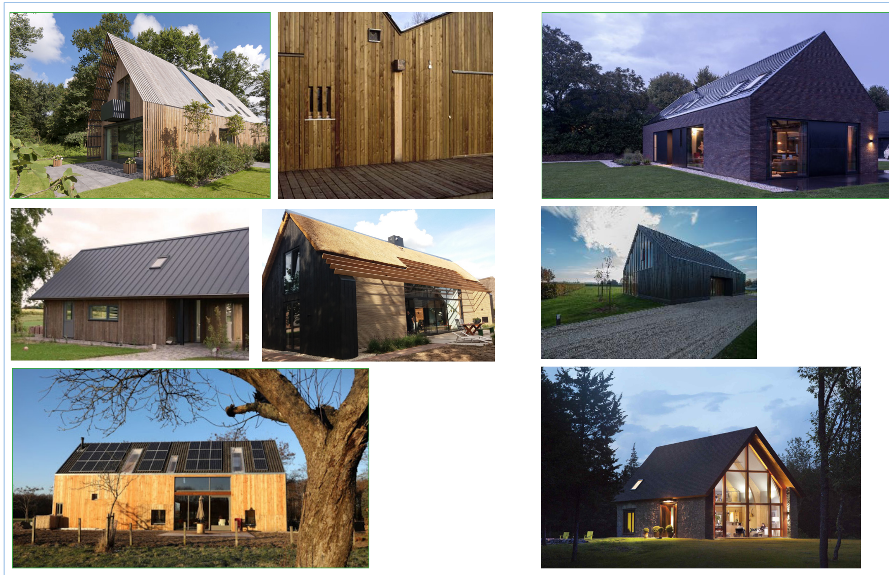
Voorbeelden van woningen in schuurarchitectuur van hout met een eigentijdse en ingetogen architectuur Bronnen: oa.. studio Ska, Maas Architecten, Weber ARchitecten, Jade architecten
