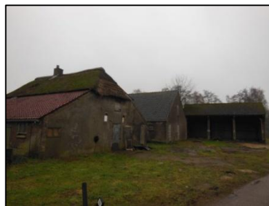
Figuur 3. Zuidelijk deel onderzoekslocatie
