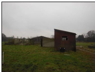
Figuur 2. Noordelijk deel onderzoekslocatie
