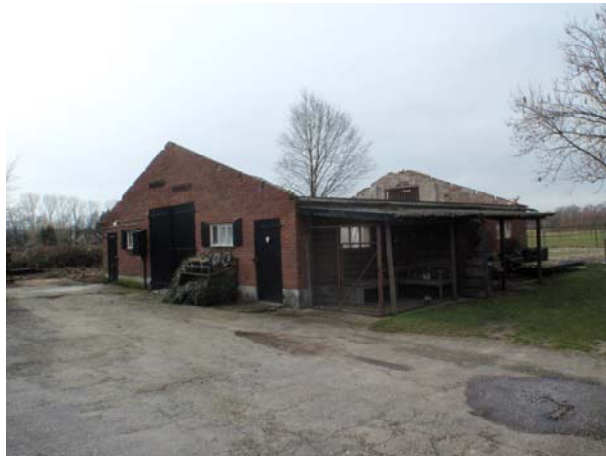
Afbeelding 5: deels gesloopte varkensschuur
