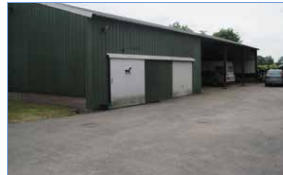
Het erf met één van de te slopen schuren.
