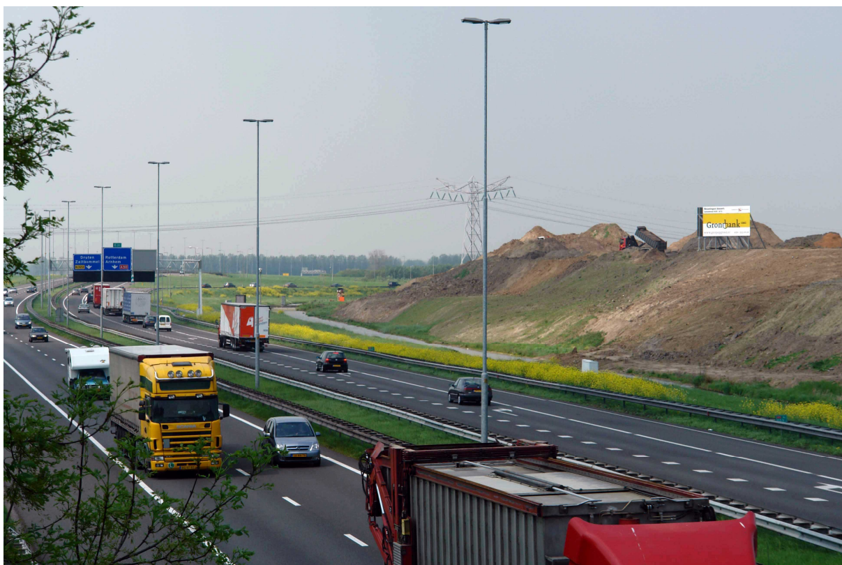
foto 13: grondwallen aan de noordzijde van de A73 ter hoogte van Ewijk
