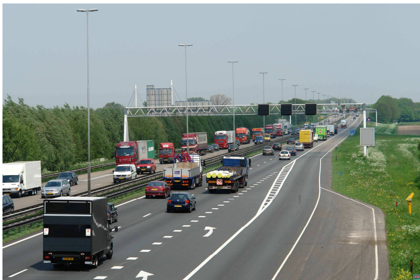
foto 2: A50 zicht van viaduct Koningstraat naar brug Ewijk
