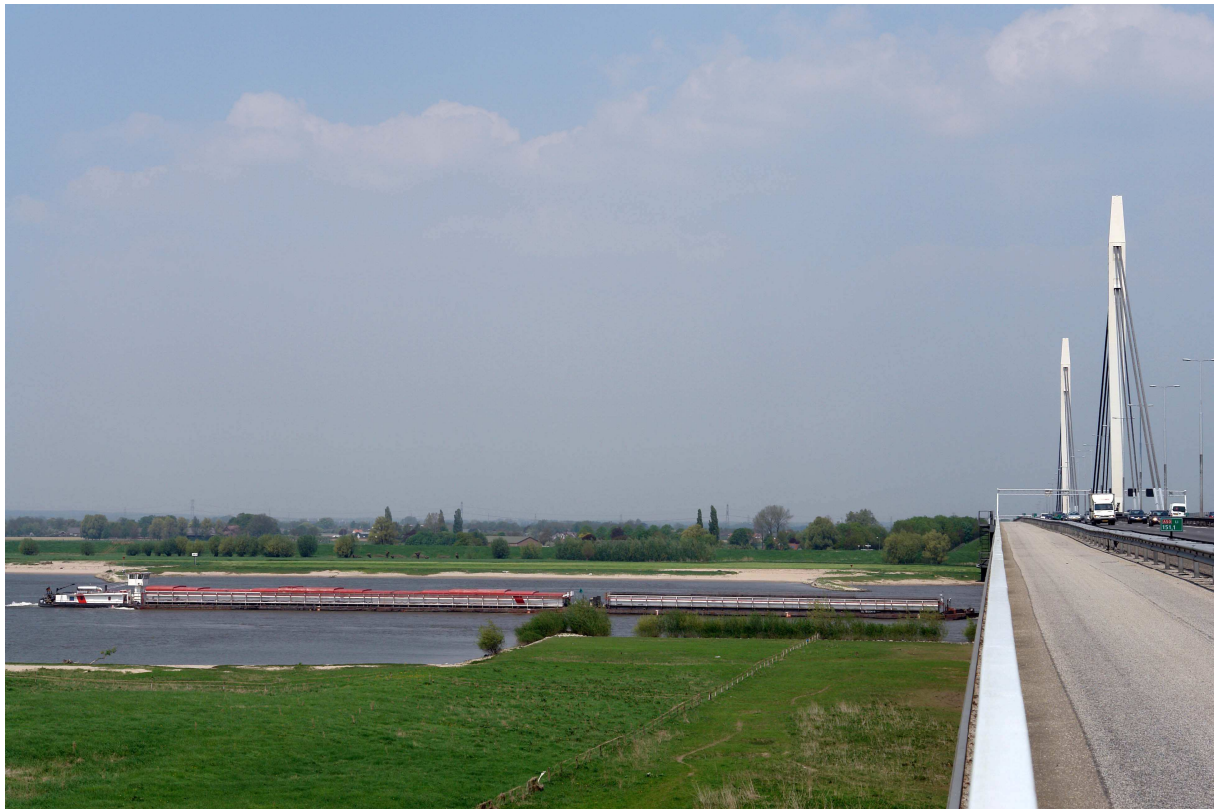
foto 14: westzijde bestaande brug Ewijk waar de nieuwe Waalbrug moet worden gerealiseerd
