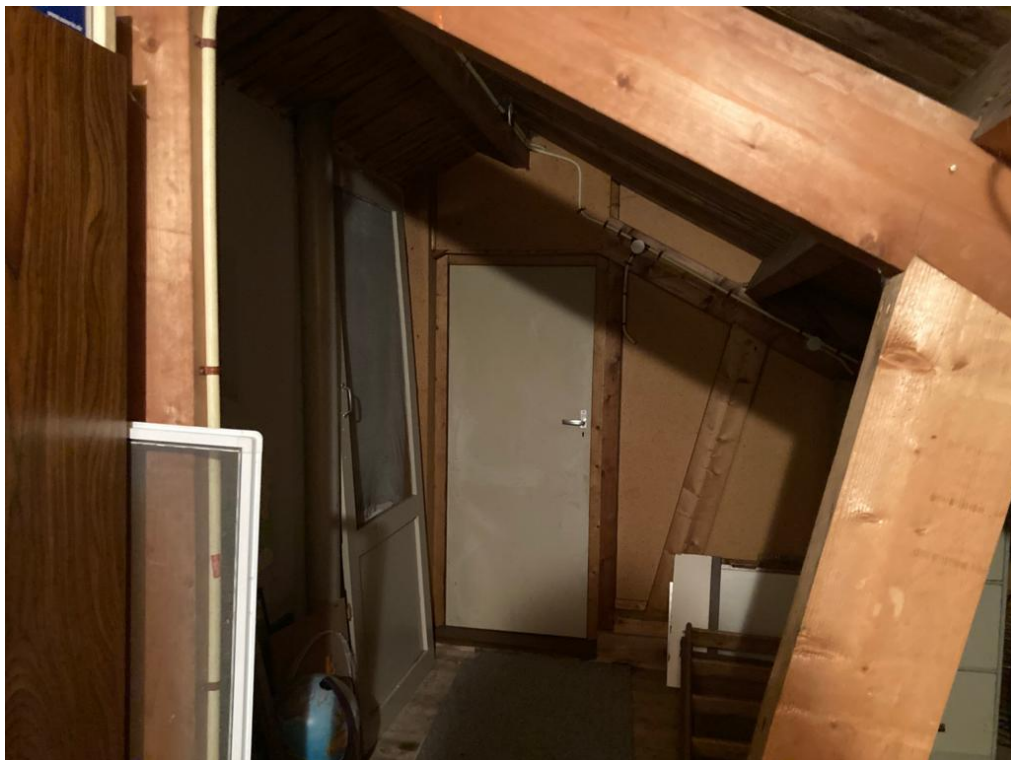
• Afbeelding 8: binnenzijde woonhuis (locatie zolder)
