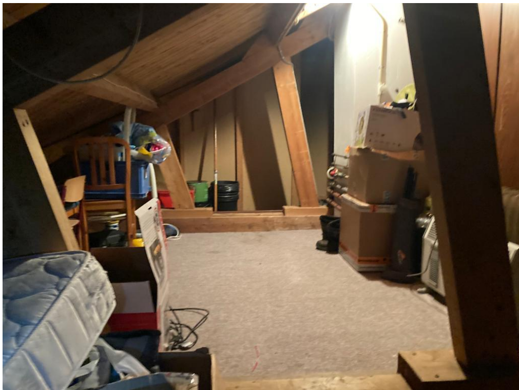
• Afbeelding 10: binnenzijde woonhuis (locatie zolder)
