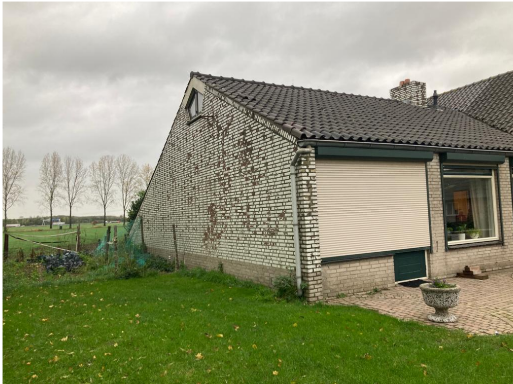
• Afbeelding 5: achterzijde aanbouw woonhuis
