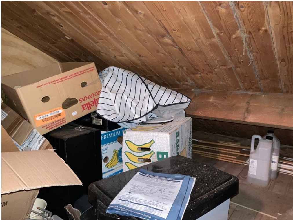
• Afbeelding 13: binnenzijde woonhuis (locatie zolder)
