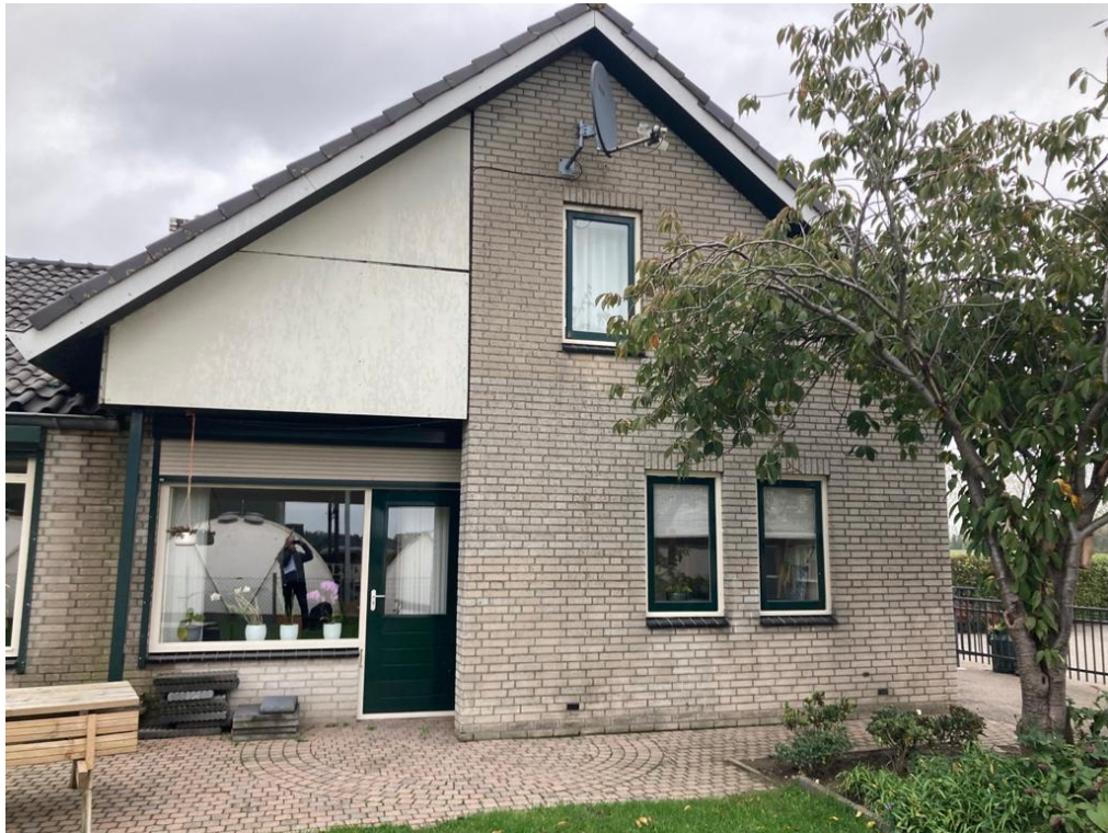
• Afbeelding 4: achterzijde woonhuis
