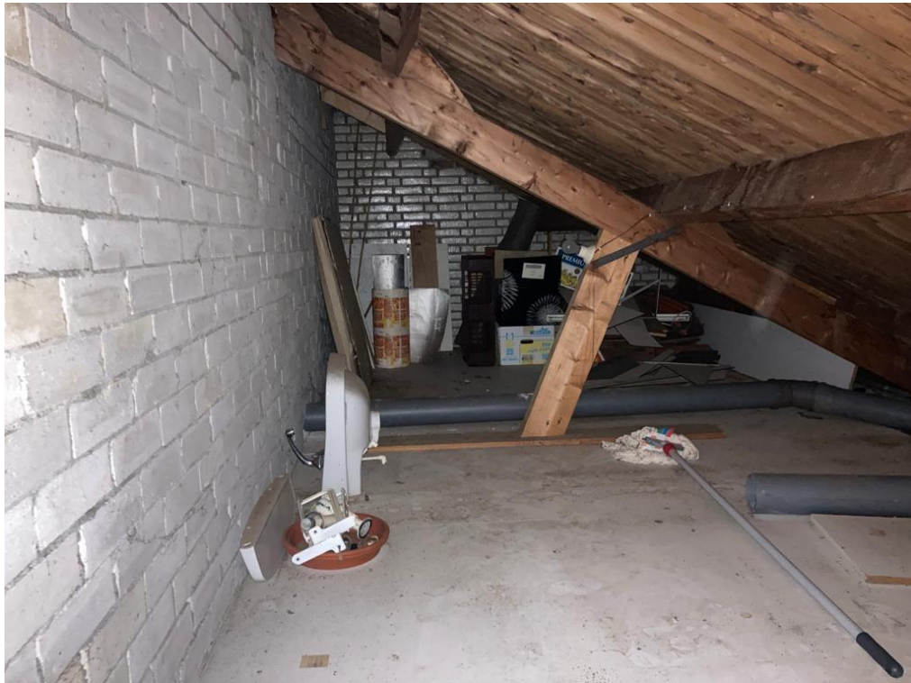
• Afbeelding 15: binnenzijde woonhuis (locatie zolder)
