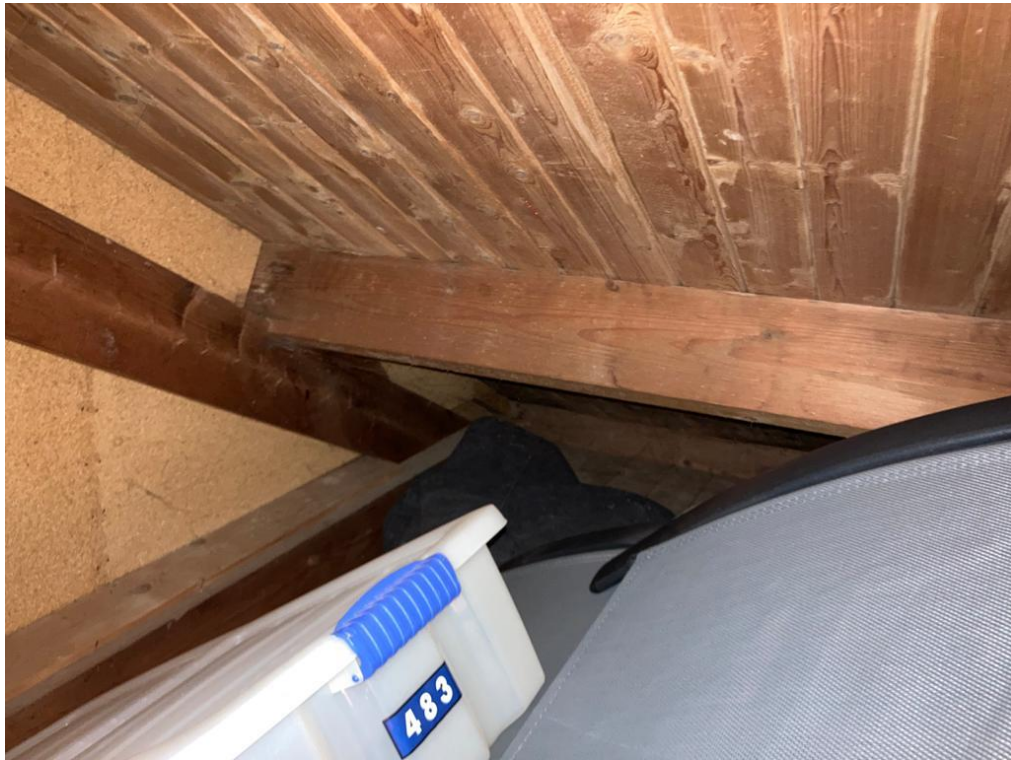
• Afbeelding 9: binnenzijde woonhuis (locatie zolder)
