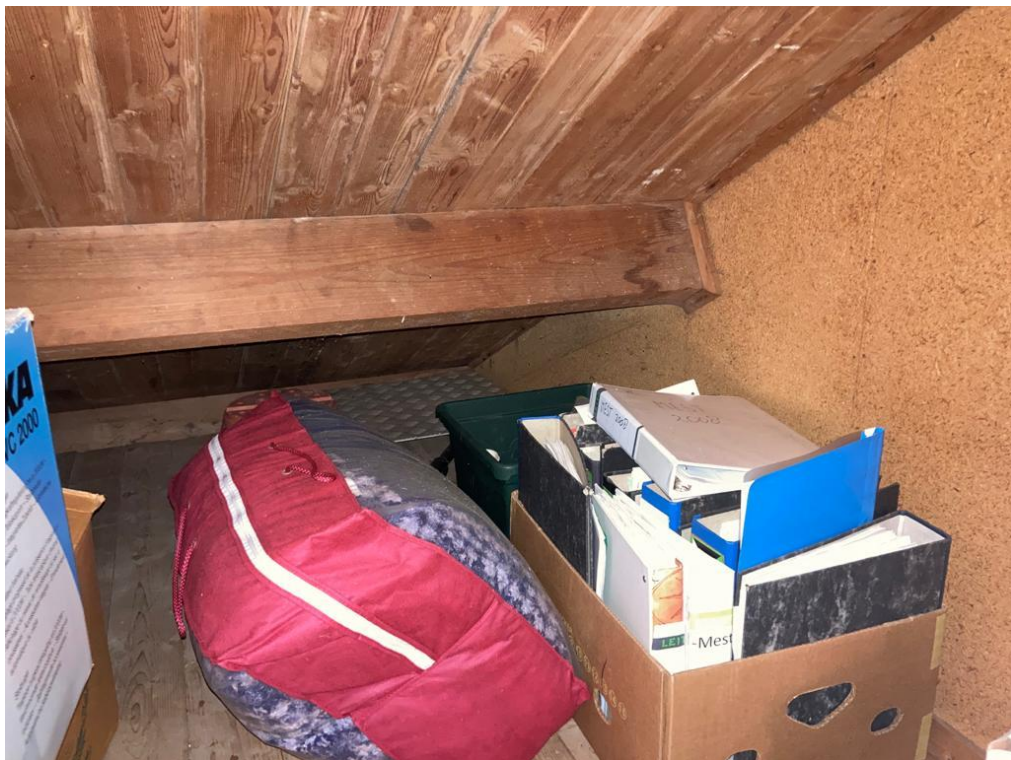
• Afbeelding 12: binnenzijde woonhuis (locatie zolder)
