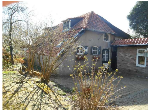
achtergevel bestaande bebouwing
