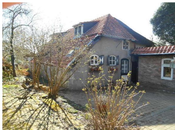
achtergevel bestaande bebouwing
