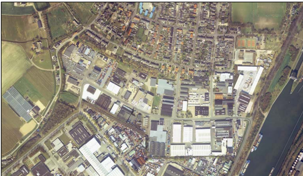
Luchtfoto van het plangebied
