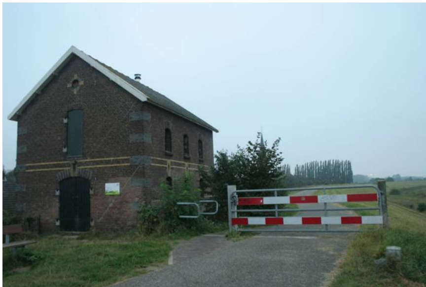
Figuur 3: Afluiting van de Waalbandijk ter hoogte van het plangebied (Foto: SAB 2009)
