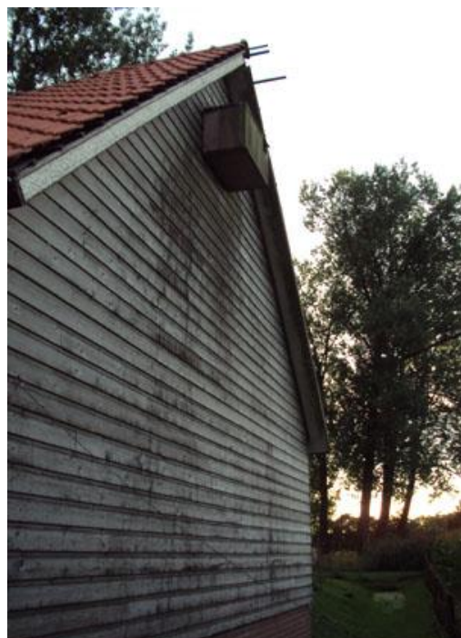
Figuur 3. Achterzijde schuurtje Koningstraat 34 met uilenkast. Onder de nok waar het steenuilkoppel zijn ingang heeft, zijn 3 zitstokken aangebracht.
