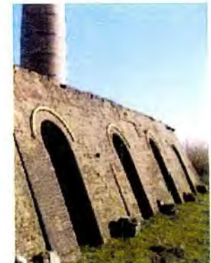
bestaande vlamoven met schoorsteen
