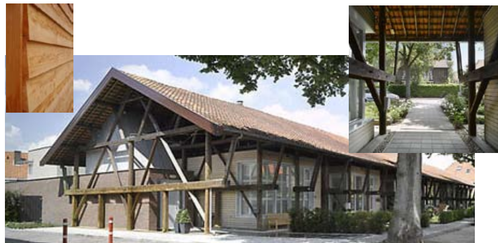
- impressie constructie in het zicht | Roemer Visscherlaan Bussum
