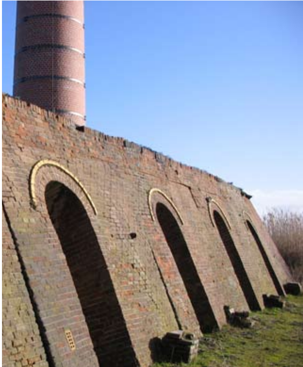
vlamoven | overlichaam en schoorsteen
