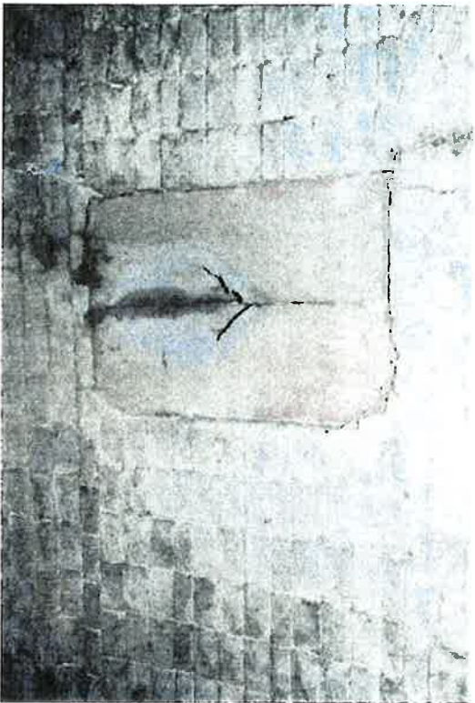
Afbeelding 28: gat in het gewelf t.b.v. de brandstoftoevoer
