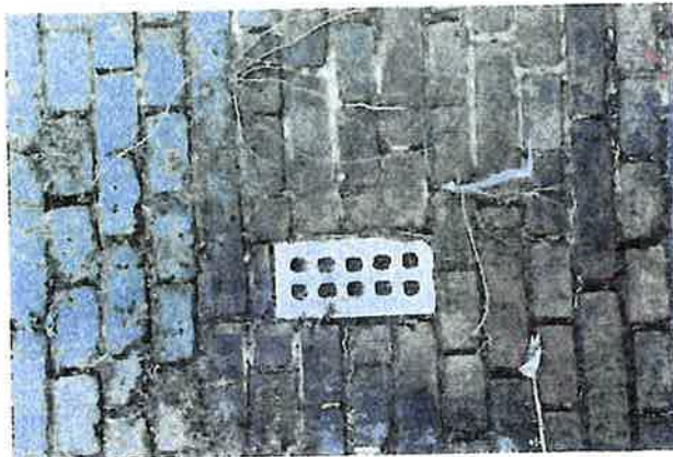
Afbeelding 14: verblendstenen als ventilatierooster in gevel
