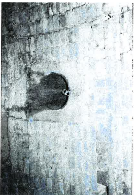
Afbeelding 29: de grote ronde gaten dienen voor de aanvoer van lucht en afvoer van waterdampen bij het opwarmen van de stenen
