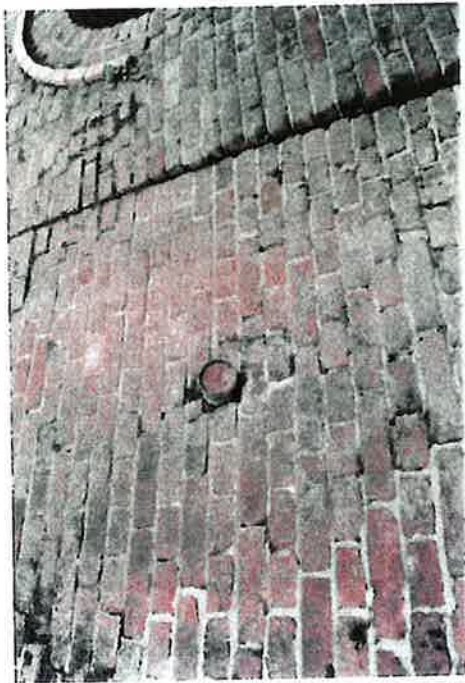
Afbeelding 13: stalen pijpen in de gevel opgenomen
