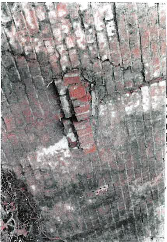
Afbeelding 15: uitspringende rollaag in westwand
