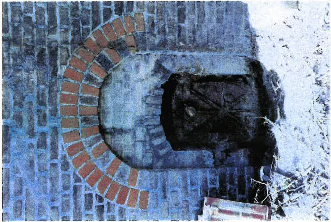
Abbeelding 18: poortje in de oostwand van de schoorsteen
