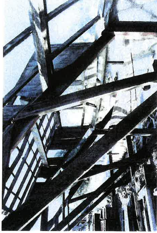
Afbeelding 40: dakkapel van binnenuit gezien
