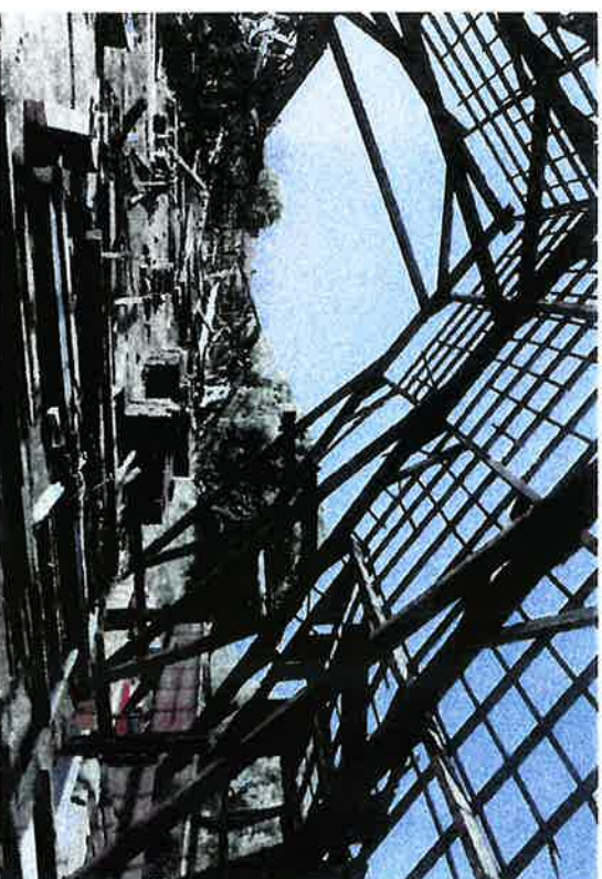
Abbeelding 36: overzicht van de noordelijke helft van de kapconstructie, gezien richting het westen
