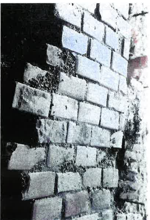
Abbeelding 35: detail van de werkvloer boven de ovens
