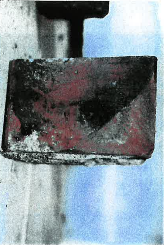
Abbeelding 21: detail radiaalsteen van het schoorsteenkanaal
