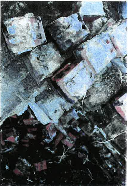
Abbeelding 20: radiaalstenen van het schoorsteenkanaal
