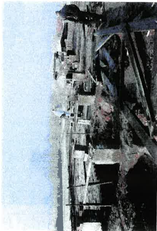
Abbeelding 32: door het midden van het ovenlichaam loopt (tussen de poeren) het rookgaskanaal
