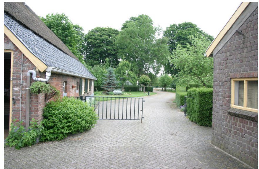
Achtererf, richting ingang oprit
