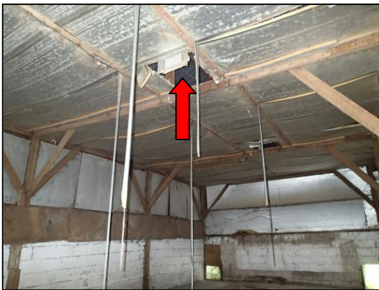
Foto 7: Ruimte boven plafonddelen in veestal
