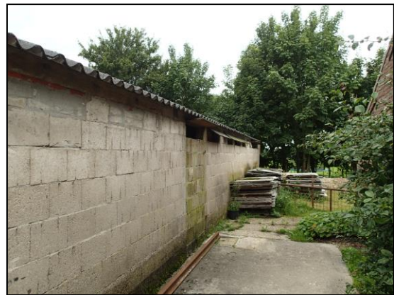
Foto 8: Openingen in muren veestal
