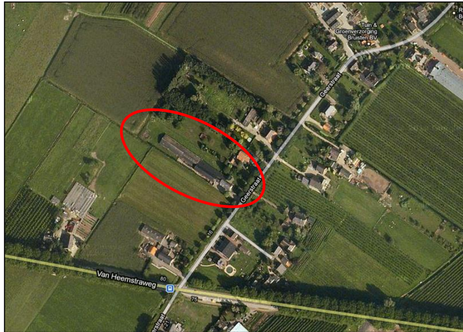
Luchtfoto met ligging van het perceel Geerstraat 16
