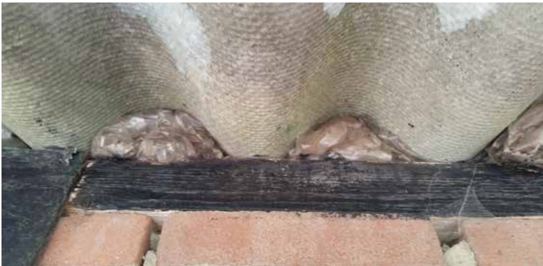
Dicht gestopte dakranden langs de varkensstal
