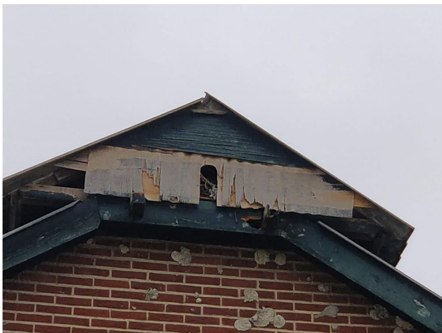
5. Kerkuilenkast in voormalige kalverenstal.
