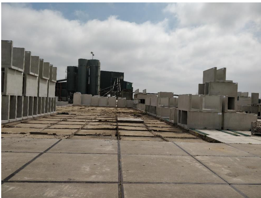
8. Opslag van stelconplaten met reeds verwijderde stelconplaten.
