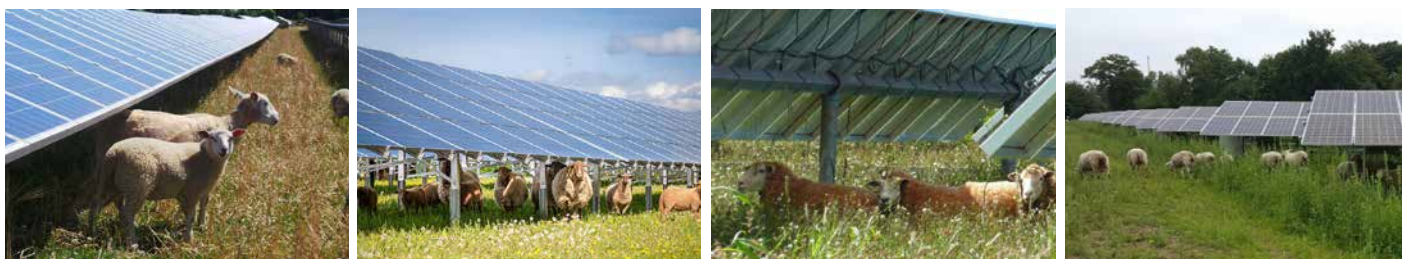
voorbeelden van bestaande opstellingen: doorloophoogte niet optimaal, veel schaduw op maaiveld door glas-foliepanelen
