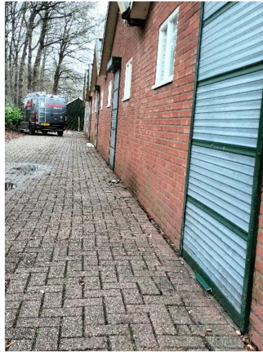
voorzijde ventilatie deuren afgesloten
