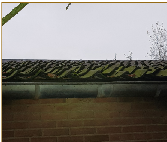
Afb. 2.9: Een foto van de achterkant van de open kapschuur (2). Er is ruimte onder de dakpannen voor huismussen.
