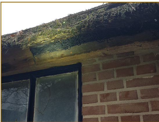
Afb. 2.12: Foto van de dakrand van de woning (5). De open plekken zijn dichtgemaakt met plastic netten. Er is daardoor geen ruimte voor beschermde soorten.
