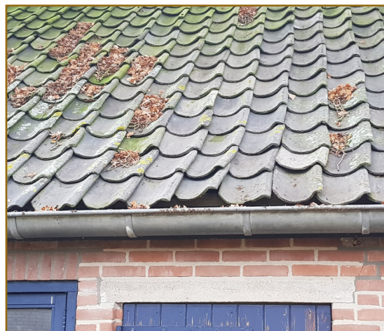
Afb. 2.10: Foto van de dakpannen van de redelijk nieuwe schuur (1). Ook ruimte voor huismussen onder de dakpannen.
