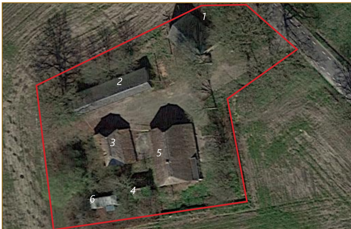
Afb. 1.1: Kaart van het plangebied (rode kader) met de directe omgeving. Bron ondergrond: GoogleEarth 2021. 1=redelijk nieuwe schuur, 2=open kapschuur, 3=oude veestal, 4=oude schuurtje, 5=woning, 6=vervallen stacaravan.
