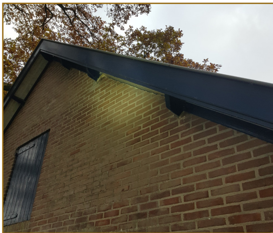
Afb. 2.7: Foto van de kopse kant van de redelijk nieuwe schuur (1). Geen ruimte voor vleermuizen vanwege het ontbreken van een open spouw.
