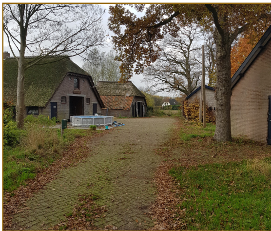
Afb. 2.1: Overzichtsfoto van het terrein met links de woning en daarnaast de oude veestal. Rechts eerst de redelijk nieuwe schuur (1) en verderop de open kapschuur.
