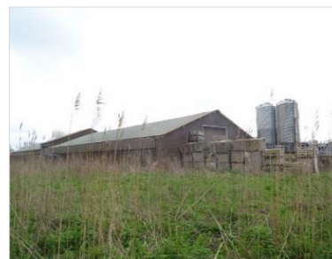
Figuur 2.5 Onbebouwd perceel aan de Walhuisweg 10, met oude stal (deze blijft behouden).
