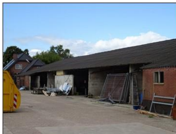
Figuur 5.2 Open schuur aan de zuidwestkant van de onderzoekslocatie met asbestplaten dakbedekking.
