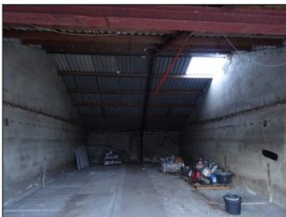
Figuur 5.2 Oude varkensschuur met één enkele laag dakbedekking.
