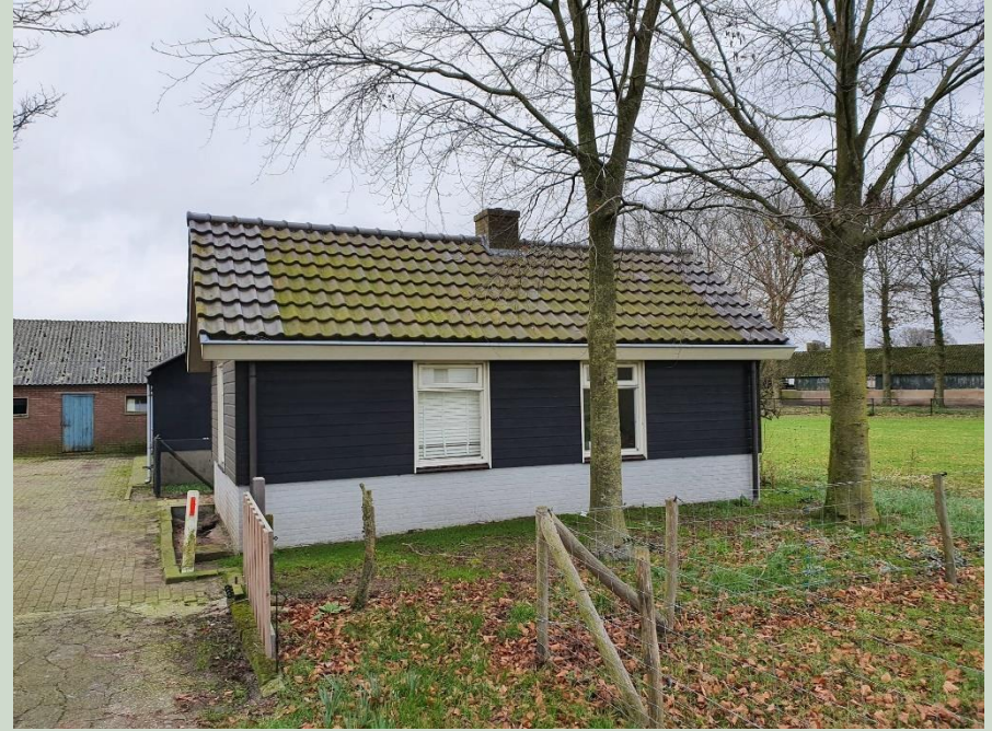
Te slopen bakhuisje/recreatiewoning
