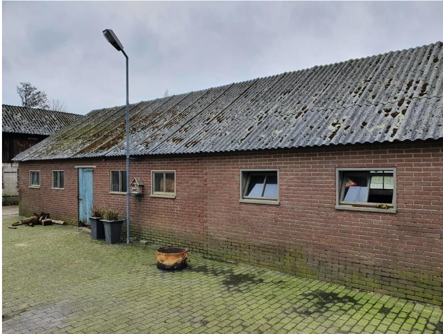
Te slopen schapenschuur
