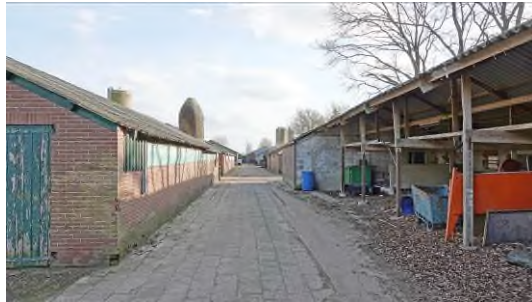
Kapschuur E, stal F
