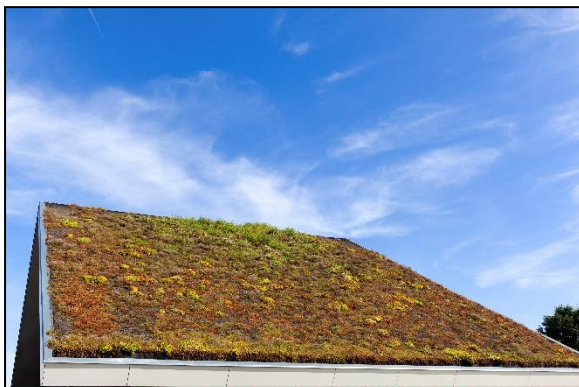
Figuur 48. Sedumvegetatie, in dit geval op een hellend dak.
