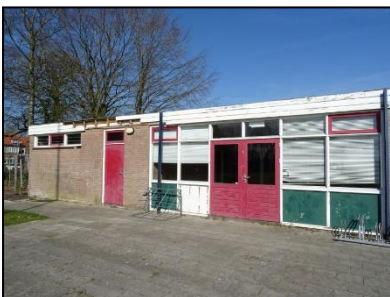
Figuur 6. Sportkantine op de onderzoekslocatie met bakstenen muur en plat dak.
