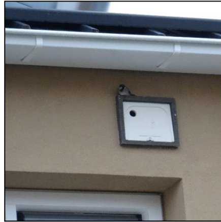
Figuur 35. Ingemetselde huismuskast in bebouwing.
