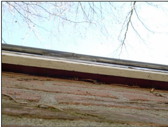
Figuur 15. Er bevindt zich geen invliegruimte tussen de betimmering en de buitenmuur van het kantinegebouw.
