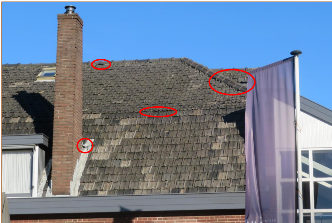
Foto 1: Enkele voorbeelden van geschikte openingen (rode cirkels) voor muizen in het dak van het restaurant (foto: R. Top).
