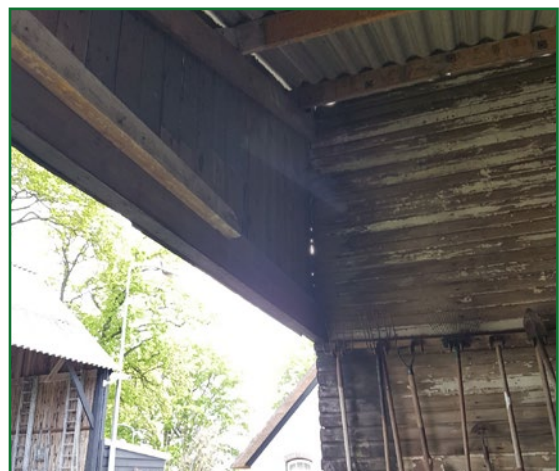
Afb. 2.6: Binnenkant gebouw 5, net als gebouw 3 vanwege de enkellaags planken en golfplattendak zonder dakbeschot ongeschikt voor vleermuizen.
