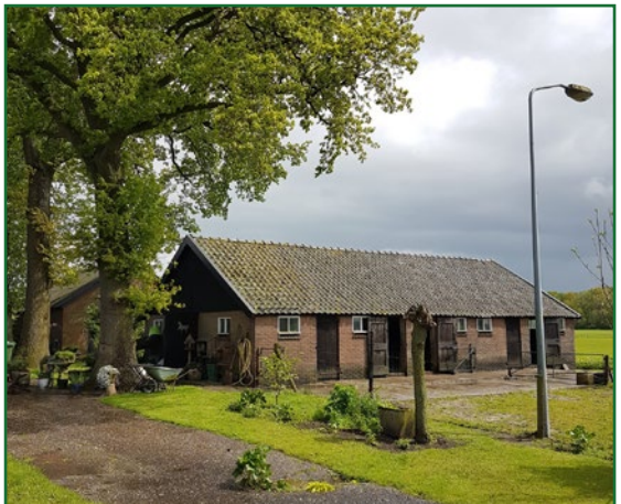
Afb. 2.10: Te slopen stal (gebouw 6). In dit gebouw zijn 2 uilenkasten geplaatst, al jaren niet meer in gebruik door uilen.
