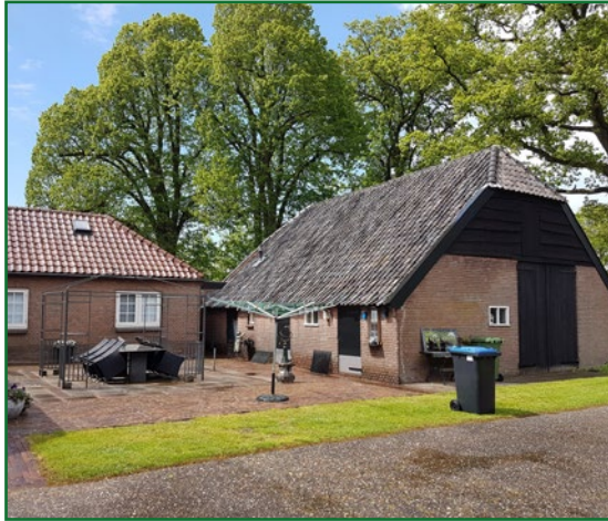
Afb. 2.1: Te behouden bijgebouwen bij de woning. Hierin nestelen mussen en de gebouwen zijn geschikt voor vleermuizen.
