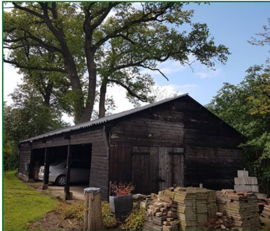
Afb. 2.3: Te slopen loods (gebouw 3).
