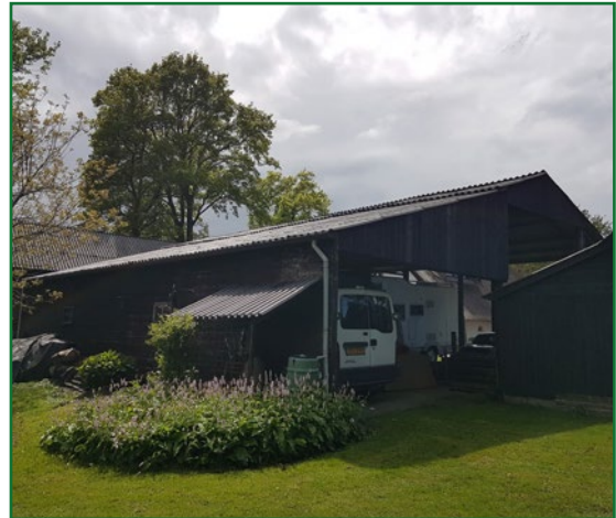
Afb. 2.4: Te slopen loods/kapschuur (gebouw 5).
