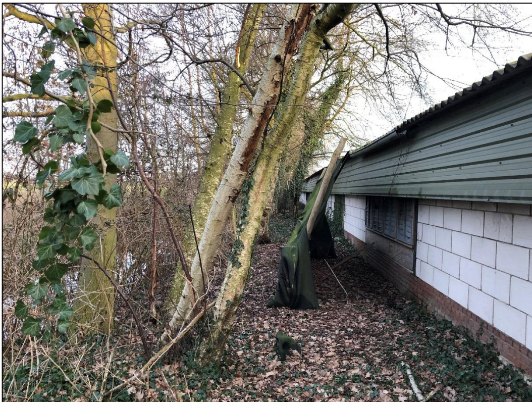
Figuur 2 De houtwal achter de langste schuur. De takken en sommige bomen hangen hier tot op de dakplaten
