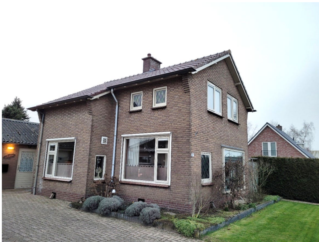
Figuur 2.7 Woonhuis met bijgebouw binnen het plangebied
