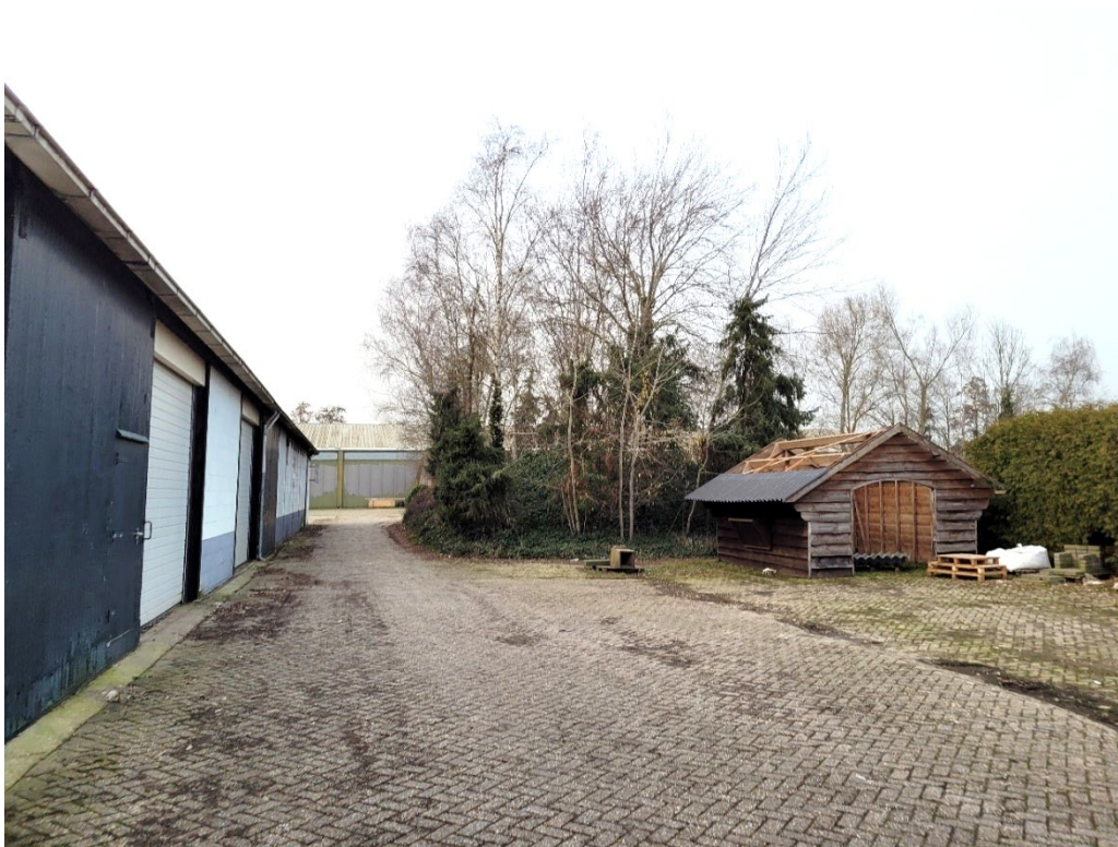
Figuur 2.6 Schuren op het terrein van het voormalige kippenbedrijf, oostzijde plangebied
