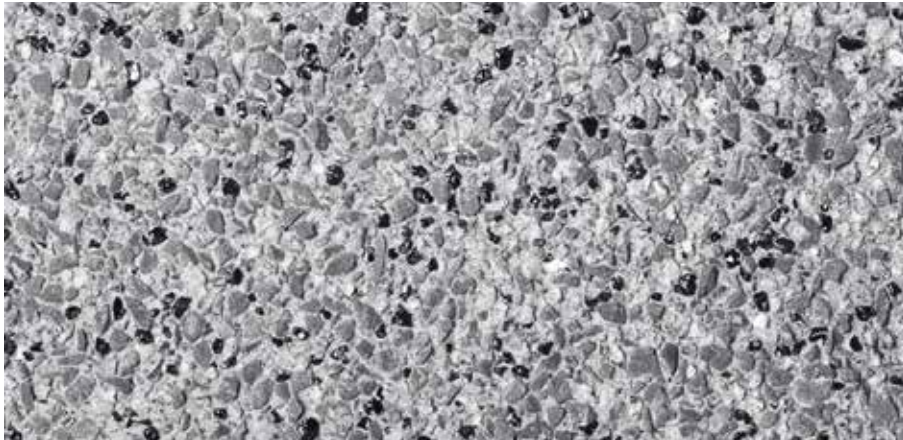
rijbaan: BSS KF gemeleerde grijze deklaag, keperverband
