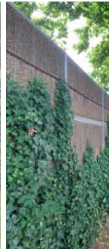
principe geluidsremmende constructie (10 kg/m 2 )
