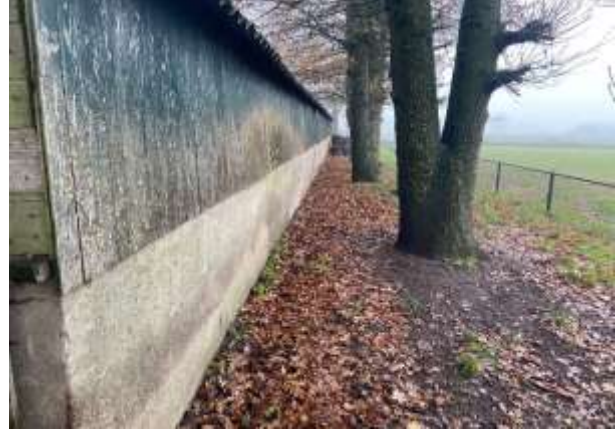
Figuur 14: Onverharde afwateringszone
