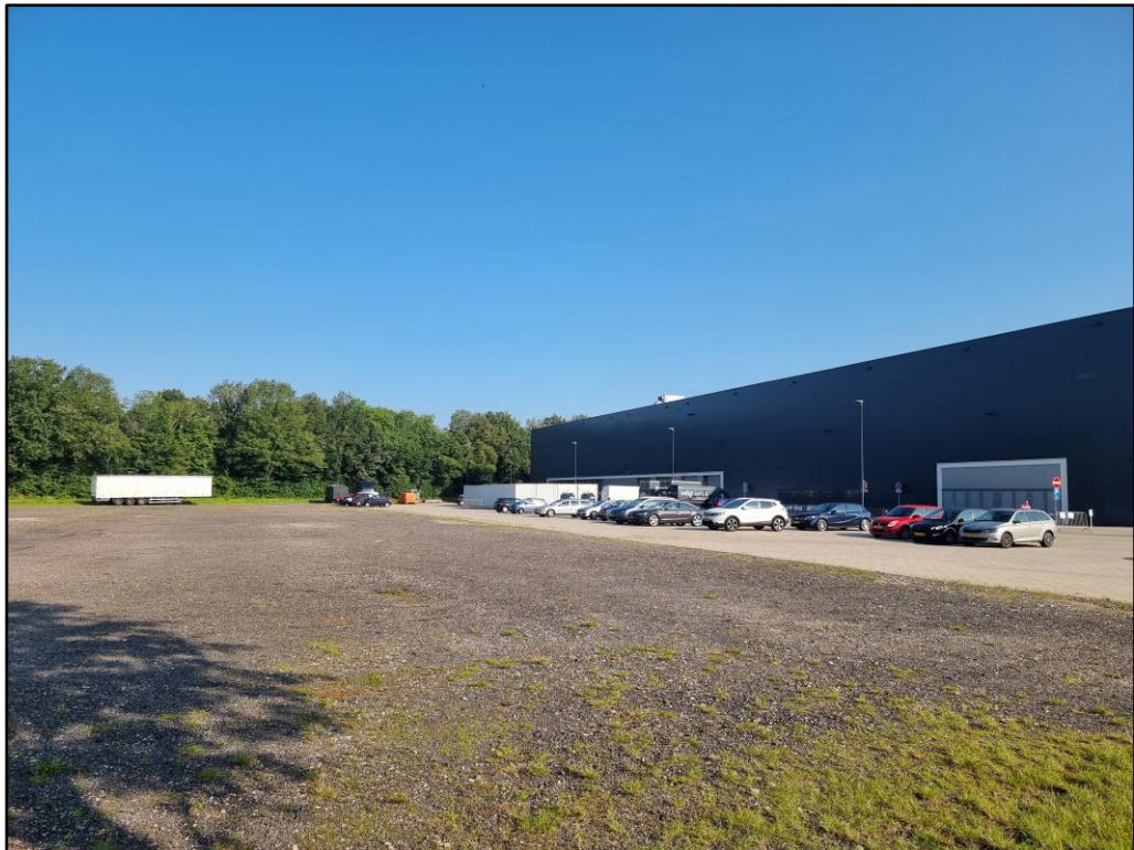
Figuur 4 De planlocatie betreft grotendeels middels puin verharde parkeergelegenheid.
