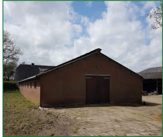
Afb. 2.2: Te slopen loods (5) gezien vanaf de oostelijke erfgrans.
