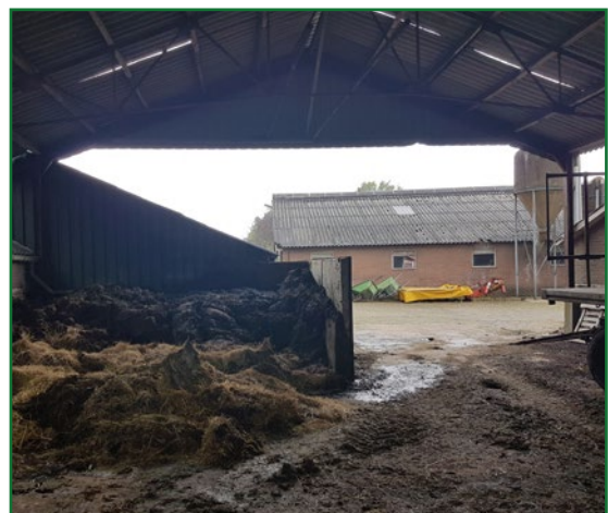
Afb. 2.6: Overkapping stal (gebouw 7) met uitzicht op de stal centraal op het erf (gebouw 6)
