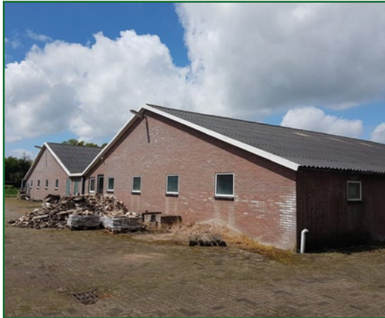
Afb. 2.9: Voorzijde pluimveestal. Deze stal is, net als de andere te slopen gebouwen, ongeschikt voor vlermuizen maar wel geschikt voor broedvogels.
