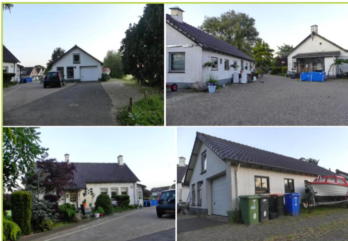
Afbeelding 3: bebouwing erf Ericaweg dat ten behoeve van de ontwikkeling geamoveerd wordt.
