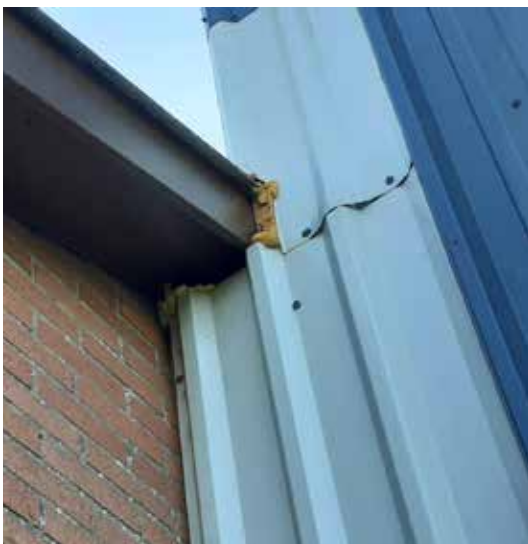
Overige openingen zijn afdicht met puschuim en andere afdichtingsmiddelen.
