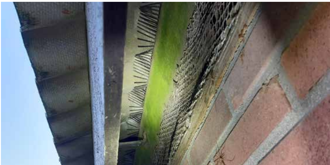
Vogelschroten en gaas om openingen af te sluiten.
