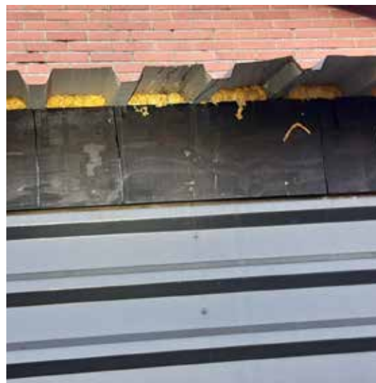
Overige openingen zijn afdicht met puschuim en andere afdichtingsmiddelen.
