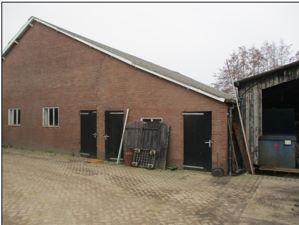
Figuur 2 Het deel van het dak van gebouw 4 waar asbestsanering plaats zal vinden.
