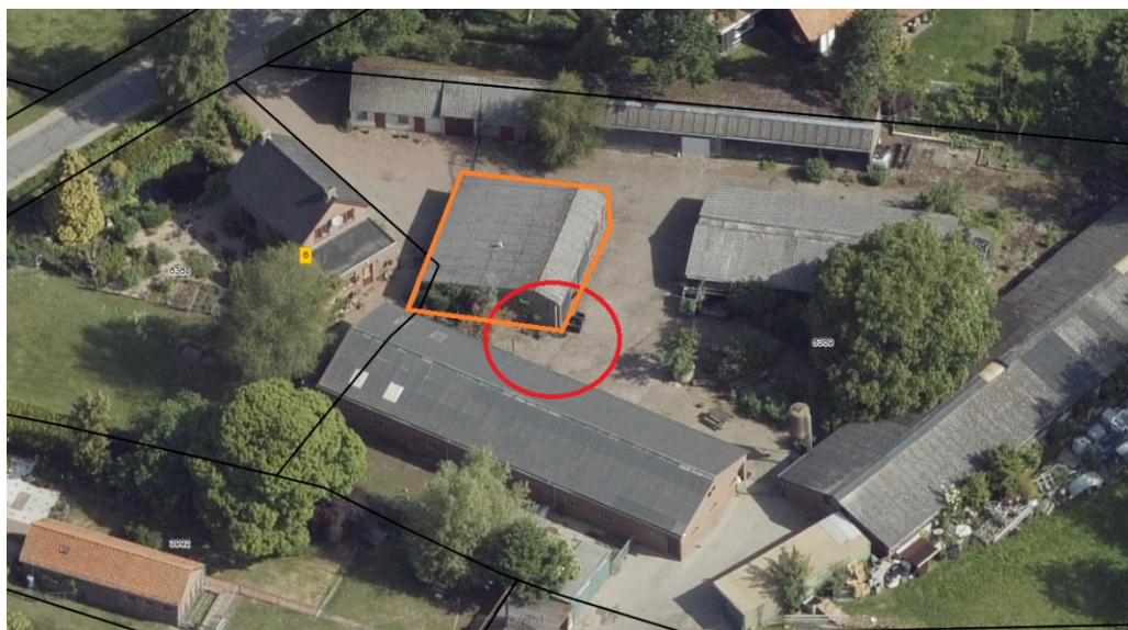
Figuur 2.1 De globale ligging van de onderzoekslocatie voor het nader asbestonderzoek is weergegeven met rood. De wagenloods is weergegeven met oranje
