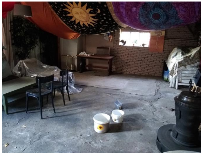
Foto 5: Wagenloods en werkplaats (1)
