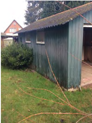
Figuur 8: Overzichtsfoto bebouwing
