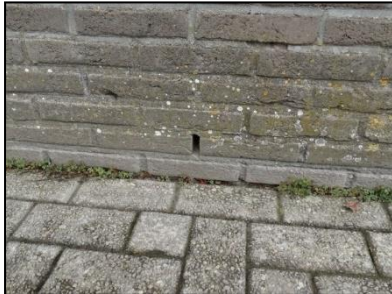
Figuur 10. Stootvoegen in de buitenmuur bevinden zich te laag om in- of uit te kunnen vliegen.
