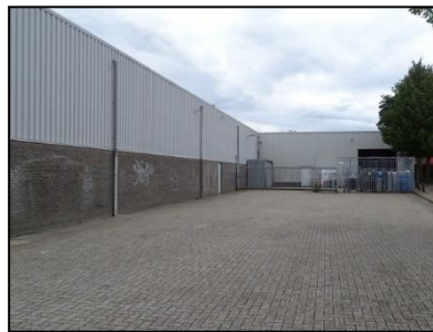
Figuur 4. Zuidzijde onderzoekslocatie.
