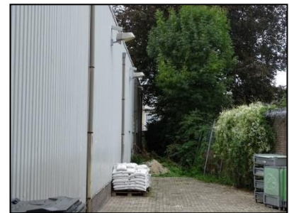
Figuur 5. Oostzijde onderzoekslocatie.
