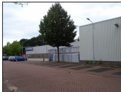
Figuur 7. Zuidzijde onderzoekslocatie.
