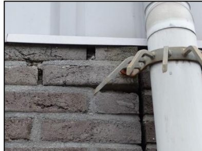
Figuur 11. Gaten en kieren op enkele meters hoogte staan niet in verbinding met ruimtes waar vleermuizen kunnen verblijven.
