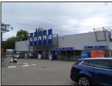
Figuur 3. Westzijde onderzoekslocatie.
