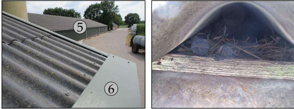
Figuur 5 Links: Het dak van varkensschuur 6 is niet toegankelijk voor huismussen. Rechts: aangetroffen huismusnestmateriaal onder het dak van varkensschuur 4.
