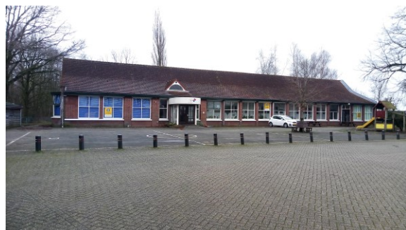
Foto 3: Entree schoolgebouw met parkeerplaatsen.
