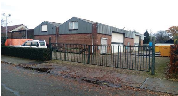
Foto 1: Onderzoekslocatie vanaf de openbare weg
