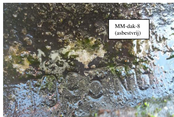
Foto 24: Asbestvrije golfplaat als dakbedekking van schuur 6. (NG-code waargenomen, 1995 NG)
