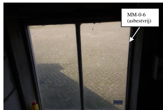
Foto 18: Asbestvrije stopverf in/aan raamkozijnen van schuur 4.
