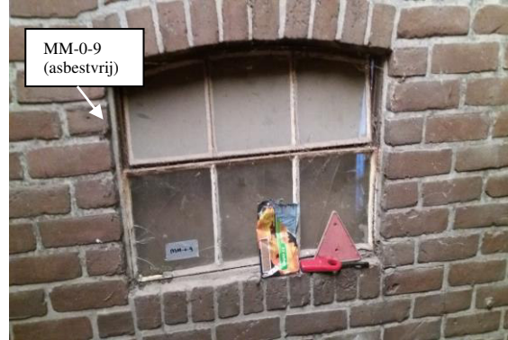
Foto 32: Asbestvrije stopverf in/aan raamkozijnen van schuur 7.
