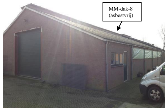
Foto 28: Geïntervieweerde schuur 6 met asbestvrije golfplaat als dakbedekking vanuit noordoostelijke richting gezien.
