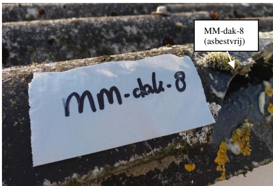
Foto 27: Asbestvrije golfplaat als dakbedekking van schuur 6.
