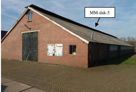
Foto 19: Geïnvesterde schuur 4 met asbesthoudende golfplaat als dakbedekking vanuit zuidoostelijke richting gezien.
