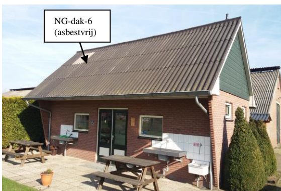
Foto 23: Geïnvesterde schuur 5 met asbestvrije golfplaat als dakbedekking vanuit zuidwestelijke richting gezien. (bouwjaar 2004 zie bijlage 5)
