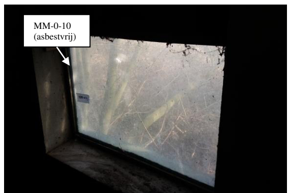
Foto 36: Asbestvrije stopverf in/aan raamkozijnen van schuur 8.
