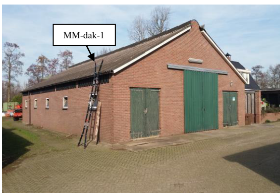
Foto 3: Geïntervieweerde schuur 1 met asbesthoudende golfplaat als dakbedekking vanuit zuidelijke richting gezien.
