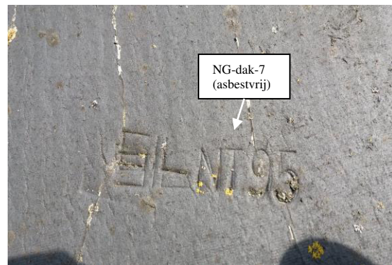
Foto 30: NT-code in asbestvrije windveren aan zuidwestzijde van schuur 6.
