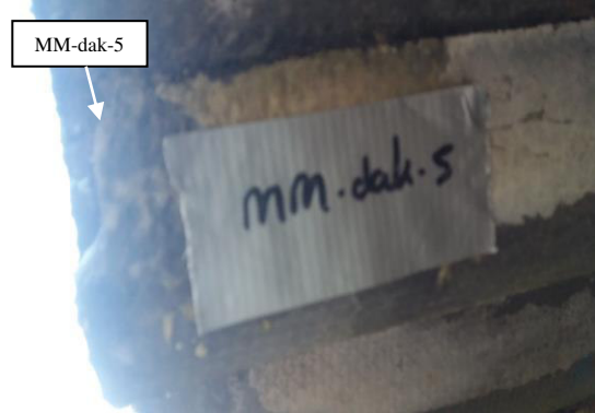
Foto 20: Asbesthoudende golfplaat als dakbedekking van schuur 4.
