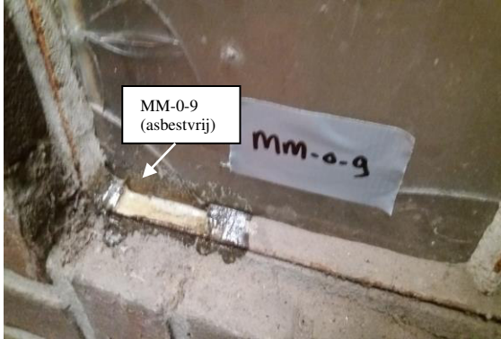
Foto 31: Asbestvrije stopverf in/aan raamkozijnen van schuur 7.
