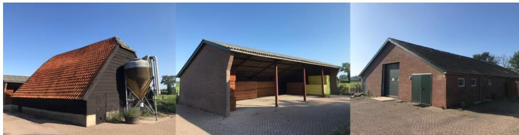
Figuur 3 Fotografische indruk van de planlocatie en de directe omgeving hiervan. Van links na recht de schuur (A), kapschuur (B) en loods (E).
