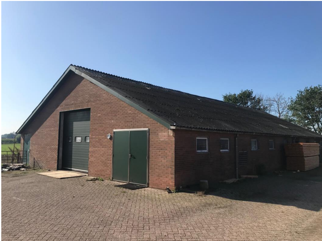
Figuur 3 De kleine loods opgetrokken uit gemetselde muren met golfplaten dak en daaronder een dakgoot.
