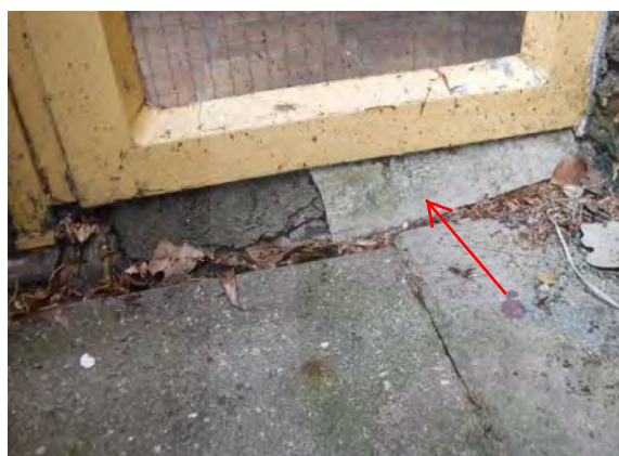
Asbesthoudende grondkering
