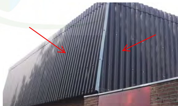
Wandbekleding (golfplaten niet asbestverdacht (2012)
