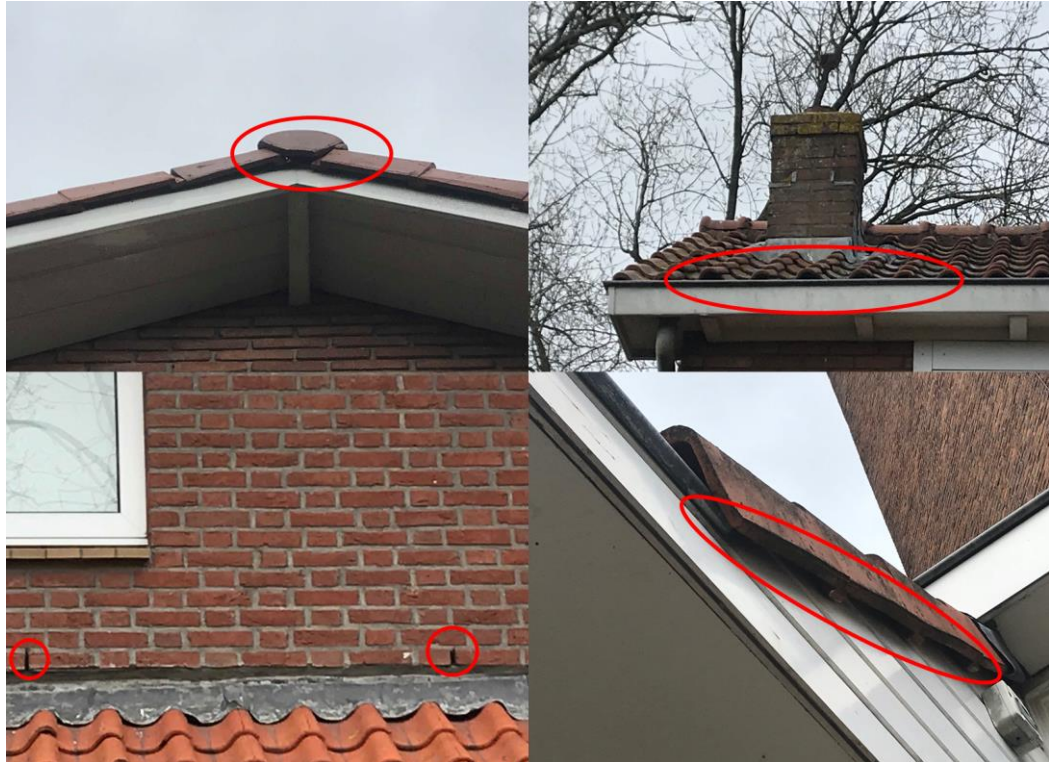
Figuur 1.3 Openingen in de woning (boven) en kerk (onder) waardoor huismussen en vleermuizen een geschikte nestlocatie of verblijfplaats kunnen bereiken.
