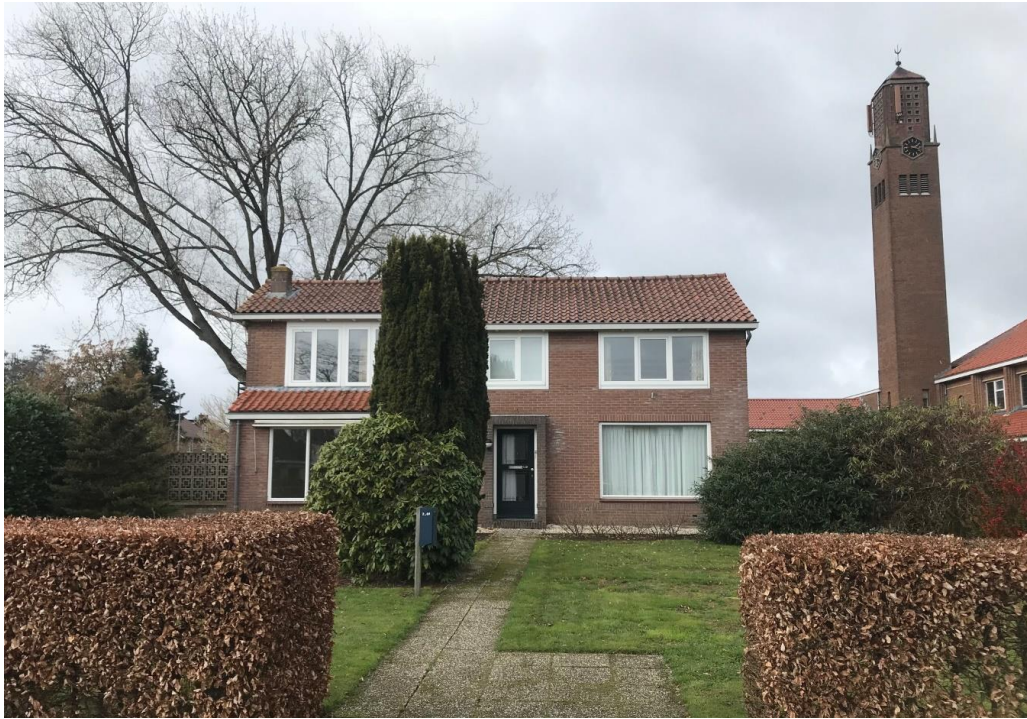
Figuur 1 De planlocatie is gelegen aan de Groen van Prinstererlaan 2 te Barneveld en bestaat uit een woning met gemetselde muur met spouw en een zadeldak met dakpannen, en een kerk.
