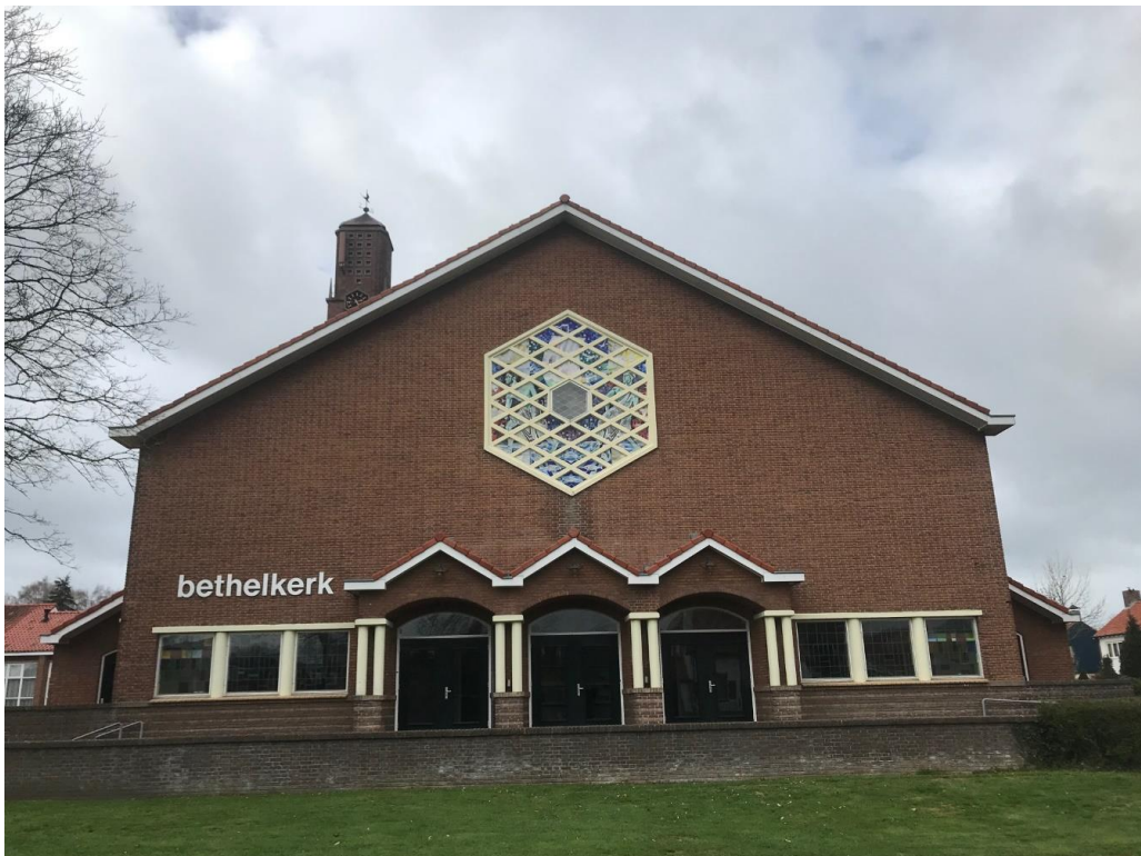
Figuur 2 De kerk is opgetrokken uit gemetselde muren met spouw en een zadeldak met dakpannen. Op de achtergrond is de kerktoren te zien. Tegen de kerk wordt een aanbouw gerealiseerd. Het gebouw blijft verder behouden.
